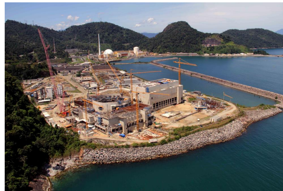
Obras da Usina Angra 3, atualmente em construção.
